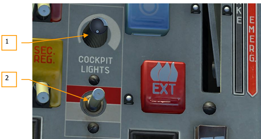
图 91：前后驾驶舱舱内照明控制系统
